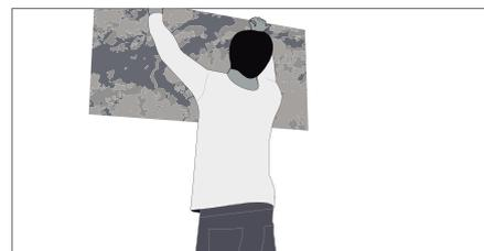
6) Utilizando las manos, un rodillo o una llana de goma, presionar levemente la Piedrafina desde el centro hacia afuera para quitar el aire atrapado y asegurar una buena adherencia del total de la superficie. Siempre realizar esta tarea con cuidado de la fuerza para evitar desplazar el adhesivo hacia afuera.
