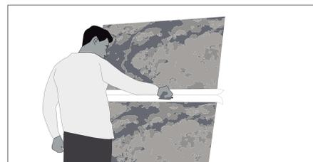
8) En caso de colocar protección selladora, se recomienda utilizar el Recubrimiento de base acuosa PF-62 para superficies rústicas y aplicar el mismo utilizando esponja o pincel. Siempre probar previamente para encontrar el brillo y la impregnación deseados antes de la instalación. (Solicitar ficha técnica del PF-62 y leer las indicaciones antes de utilizar el producto).
